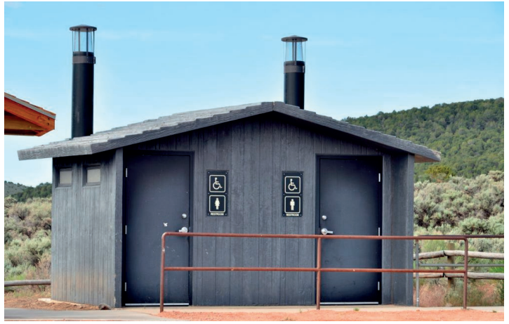
KOMÍNOVÉ ZÁCHODY SÚ SUCHÉ ZÁCHODY, Z KTORÝCH SA NAHROMADENÝ ODPAD PRAVIDELNE VYVÁŽA. DIZAJNOM ZAPADAJÚ DO PRÍRODNÉHO PROSTREDIA.
